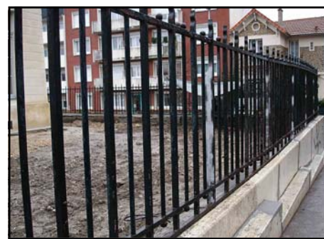
Réhabilitation des grilles
