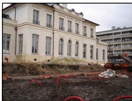
Préparation terrasse et parterres
