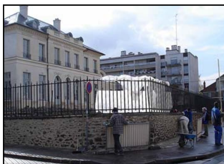
Rejointoiement des murs
