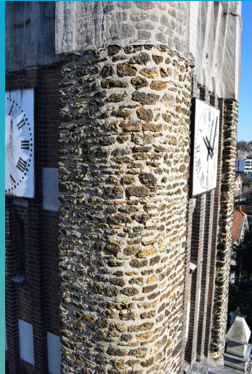
Campanile : parement des angles en meulière
