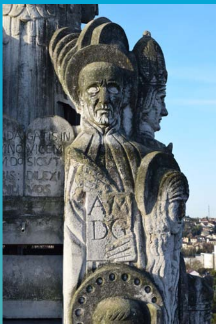
Etat avant restauration photo Gatier
