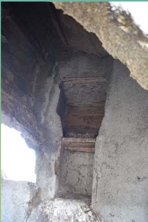
Coffrage bois arrière statue - photo Gatier
