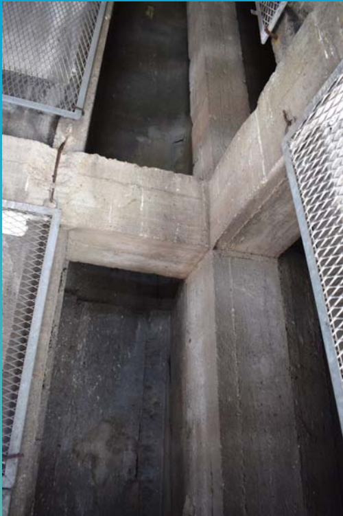
Campanile : ossature intérieure en béton
