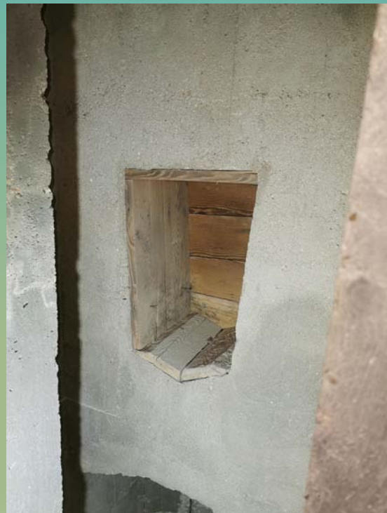
coffrage bois arrière statue
