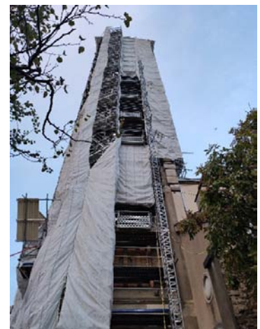
Le campanile entre juillet et septembre 2023 : échafaudage et bâches de protection
