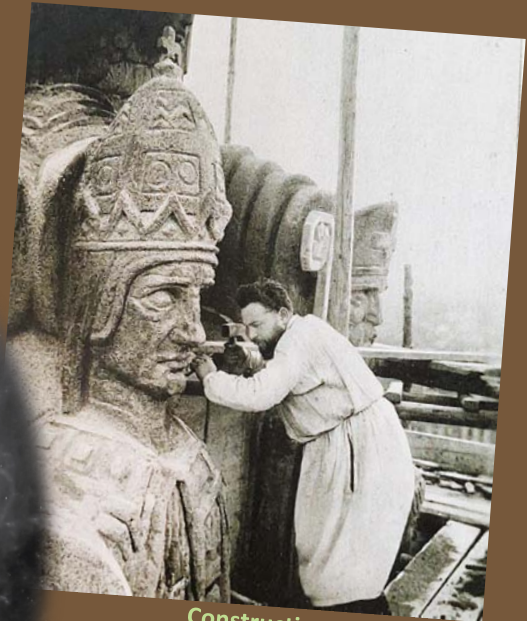
Construction du campanile Sculpture par Carlo Sarrabezolles 1926
