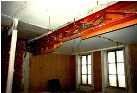
Renfort sous le campanile
