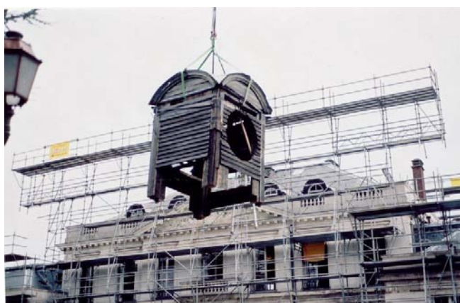
Descente de l'horloge
