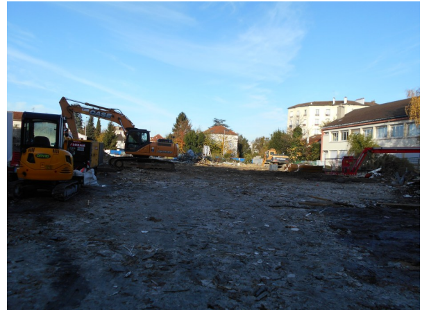
2017 - Démolition du centre
